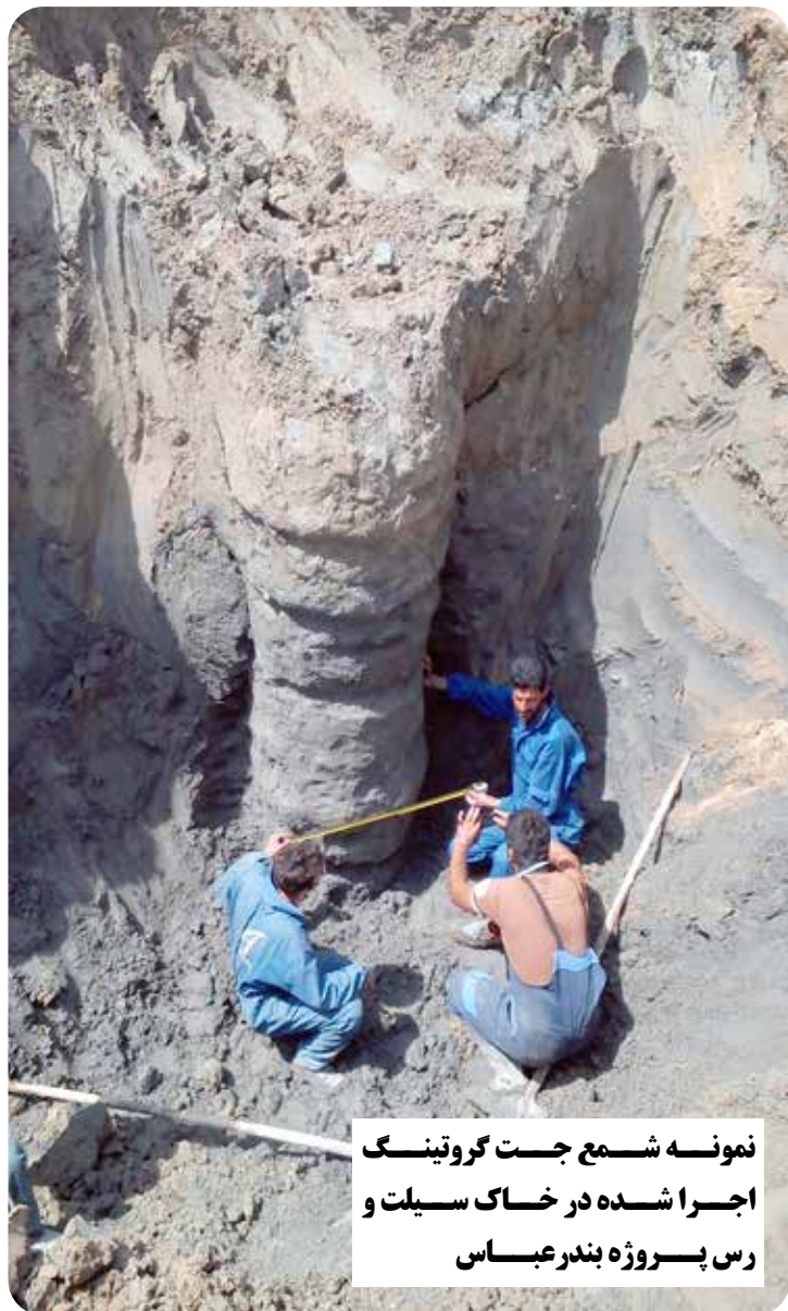
نمونه شمع جت گروتینگ اجرا شده در خاک رس پروژه مصلی بندرعباس
