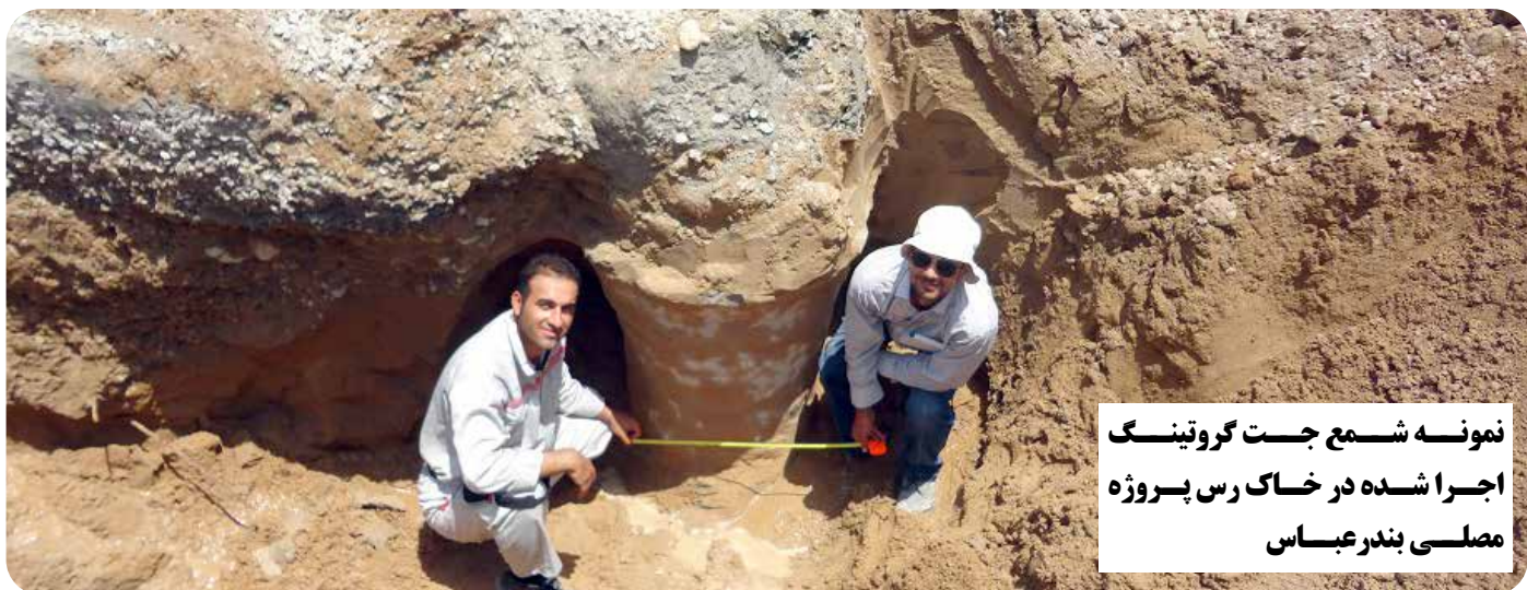
نمونه شمع جت گروتینگ اجرا شده در خاک رس پروژه اسکله p3 و p4
